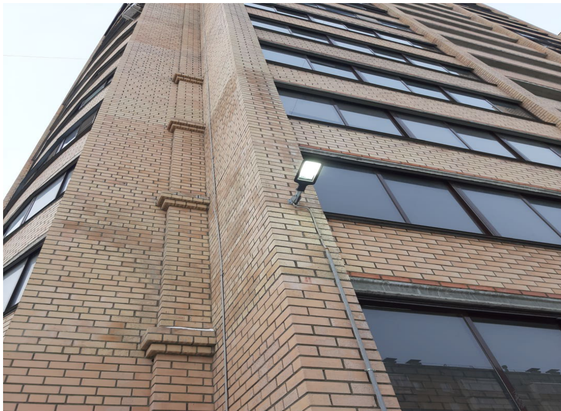
Установка 2х прожекторов
