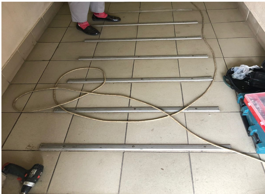
Монтаж противоскользящего покрытия
