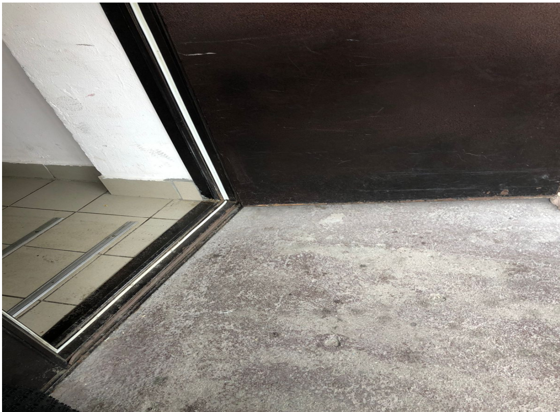
Монтаж противоскользящего покрытия
